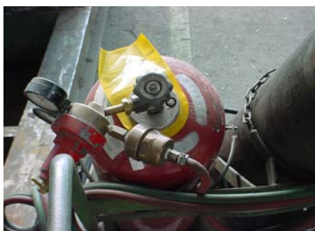
Fig. 40 – Válvula de segurança do cilindro de acetileno
